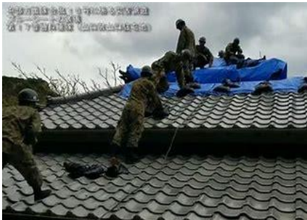
令和元年の台風15号で被災した屋根の補修に当たる17普連の隊員
